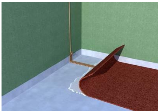
Przygotowanie uziemienia
