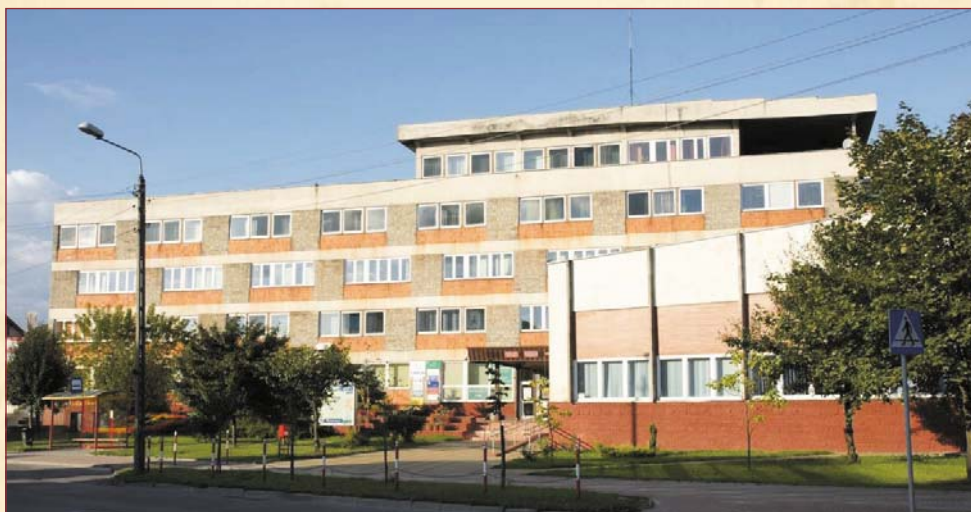
Budynek przy ul. Szosa Zambrowska. Fot. zbiory własne pracowników
