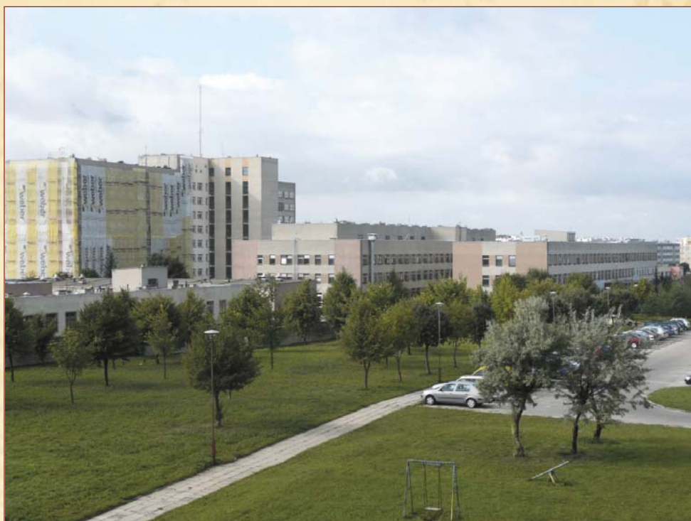
Budynek główny szpitala w trakcie trwania termomodernizacji. Fot. Jan Orłowski
