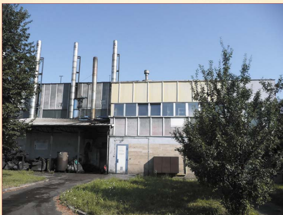
Spalarnia Szpitala Wojewódzkiego w Łomży. Fot. Jan Orłowski
