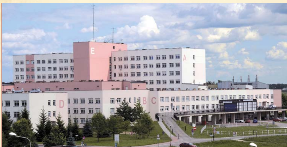
Budynek główny szpitala po termomodernizacji. Fot. Karol Babel – Telewizja Narew
