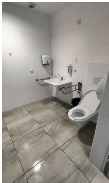
Zdjęcie nr 11: Toaleta przystosowana dla osób z niepełnosprawnościami / SOR/Izba przyjęć
