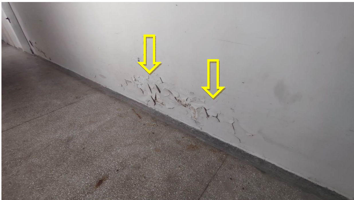
Zdjęcie nr 05 – Zawilgocenie ściany wewnętrznej przy posadzce w piwnicy
